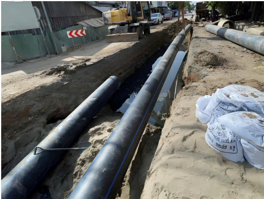
OD500 pipeline laid in the trench along the road បំពង់ OD500 ដាក់ក្នុងប្រឡាយតាមដងផ្លូវ
