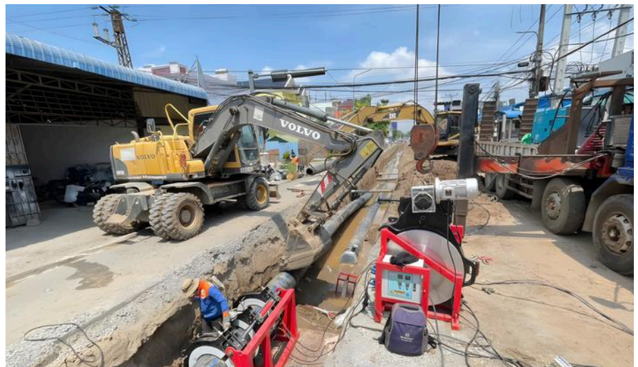
Welding beside the open trench ការផ្សារក្បែរប្រឡាយ
