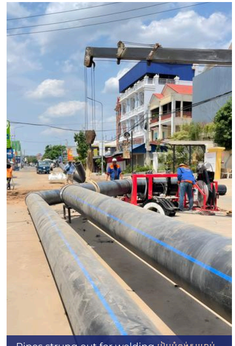
Pipes strung out for welding រៀបបំពង់សម្រាប់ផ្សារ
