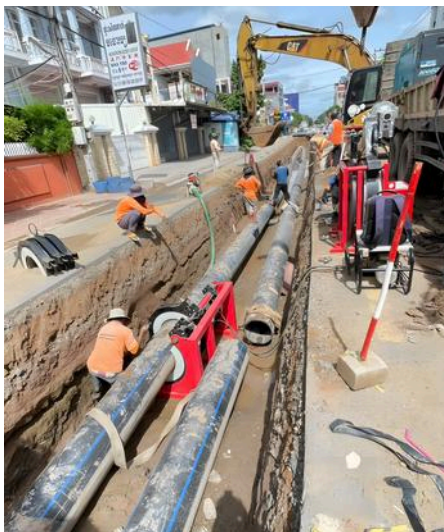
Excavation and laying ការដីក និងដាក់បំពង់
