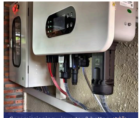
Commissioning – inverter & battery ដាក់ឱ្យ ដំណើរការ – អ៊ីនវ៉ែតទ័រ និងអាកុយ
