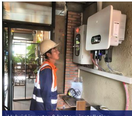
Hybrid inverter & battery installation តម្លើងអ៊ីនវ៉ែតទ័រកូនកាត់ និងអាកុយ
