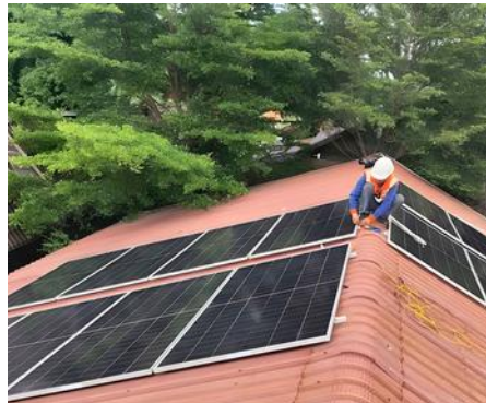
Rooftop module installation តម្លើងផ្ទាំងសូឡាលើ ដំបូល
