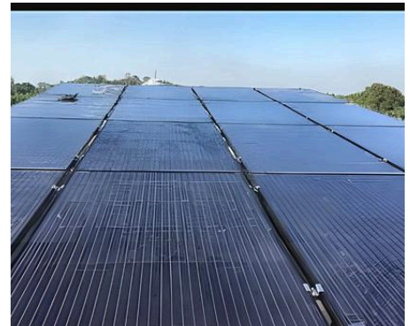
Module rows on mounting rails ជួរ ផ្ទាំងសូឡាលើរនាំង
