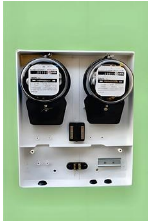
Meter box – 2 single-phase meters ប្រអប់ទាញកាស្ទុង – 2 ទាញកាស្ទុង
