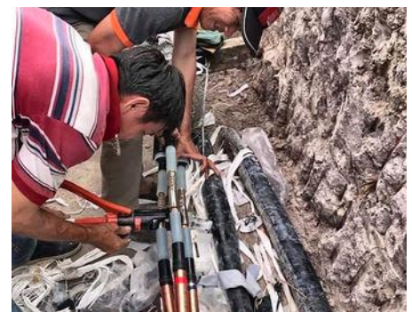
MV cable jointing ការភ្ជាប់ខ្សែតង់ស្យុងមធ្យម
