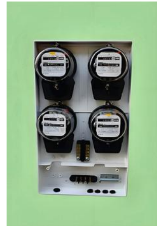
Meter box – 4 single-phase meters ប្រអប់ទាញកាស្ទុង – 4 ទាញកាស្ទុង
