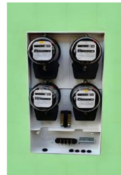
4-meter box – interior with meters ប្រអប់ 4 នាឡិកា – ផ្ទៃក្នុងខាងក្នុង
