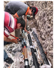
MV cable jointing on site ការតភ្ជាប់ខ្សែតង់ស្យុងមធ្យម
