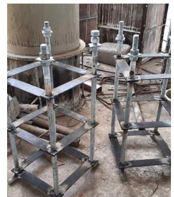
Anchor cages on site ទ្រុងបិទ្បងទៅការដ្ឋាន
