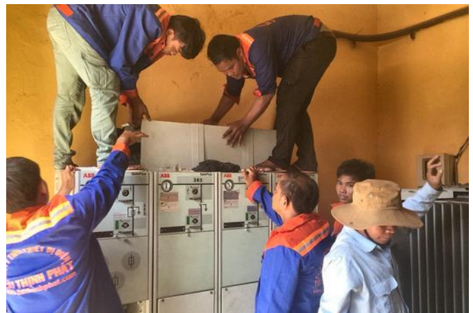
RMU installation on site ការតម្កើងទូ RMU នៅការដ្ឋាន
