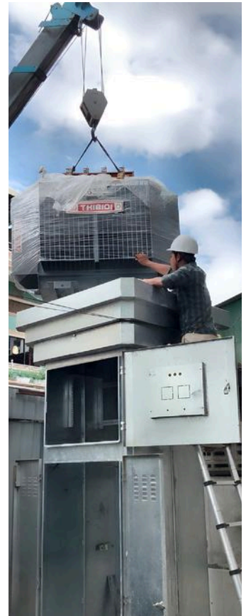
Lifting transformer – 630 kVA Phnom Penh លើកត្រង់ស្នូ – 630 kVA ភ្នំពេញ
