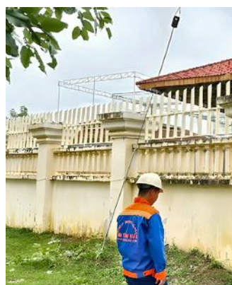
100 kVA · Svay Kravan 100 kVA · Svay Kravan
