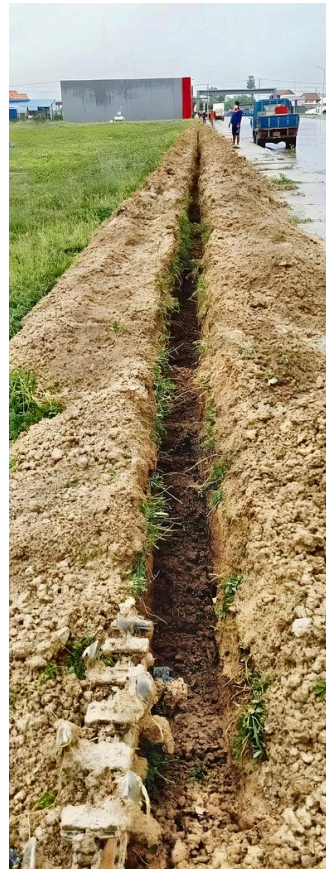
Cable trenching – 1,600 kVA Kerry ដឹកប្រឡាយខ្សែ – 1,600 kVA Kerry
