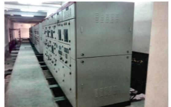
MSB line-up at factory test រួមទូរមេ ពេលតេស្តនៅរោងចក្រ
