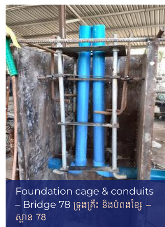
Anchor cages – Bridge 78 ទ្រុងប៊ូឡុង – ស្ពាន 78
