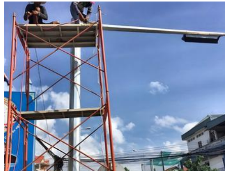
NR2 – arm installation ផ្លូវជាតិលេខ 2 – តម្លើងដៃសសរ
