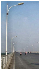
Street lighting poles សរសៃបំភ្លឺផ្លូវ
