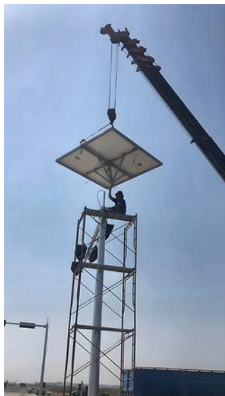
Lifting solar panel frame លើកគ្រោងផ្ទាំងសូឡា
