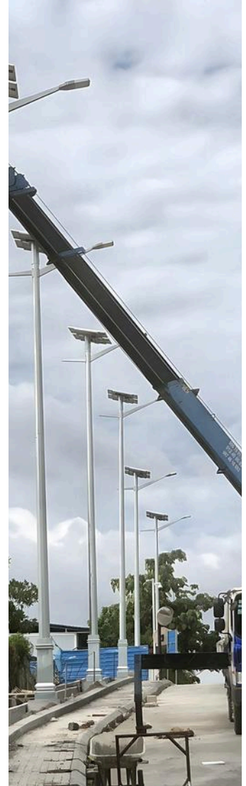
Solar pole erection – KD Resort, Sihanoukville លើកសសរសូឡា – KD Resort ក្រុងព្រះសីហនុ
