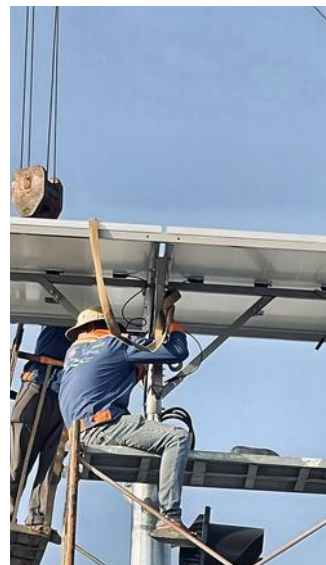
Panel installation at height តម្លើងផ្ទាំងសូឡានៅទីខ្ពស់
