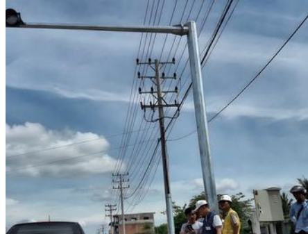
NR21 – signal pole & controller ផ្លូវជាតិលេខ 21 – សសរ និងទូបញ្ជា
