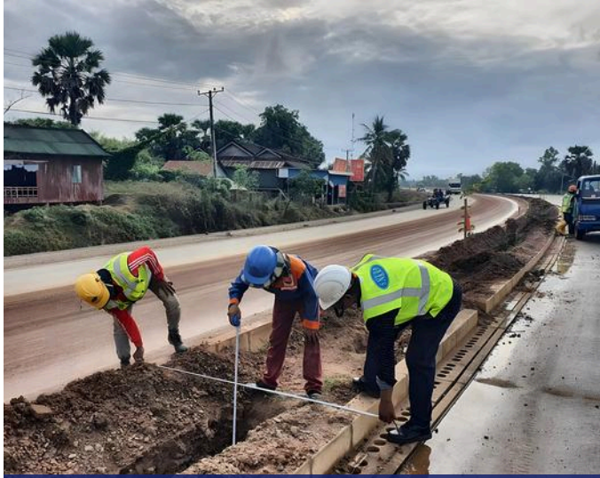
Cable trenching – NR5 Package 2 (SMCC) ដឹកប្រឡាយខ្សែ – ផ្លូវជាតិលេខ 5 កញ្ចប់ទី 2 (SMCC)
