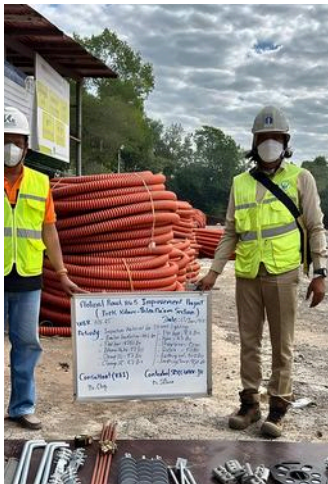
Material inspection – NR5 Package 2 (SMCC) ត្រួតពិនិត្យសម្ភារៈ – ផ្លូវជាតិលេខ 5 កញ្ចប់ទី 2 (SMCC)
